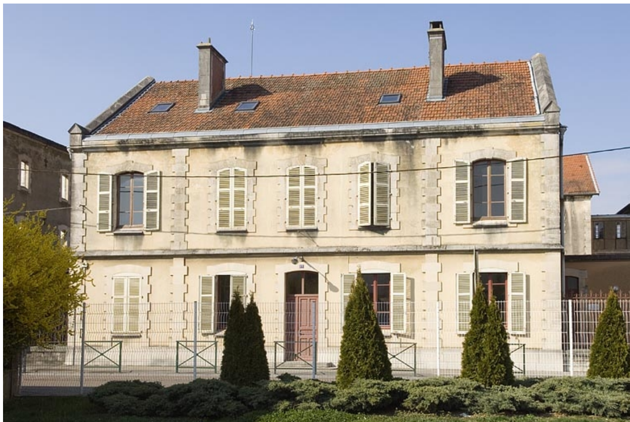
Bâtiment des bureaux. Façade antérieure.
