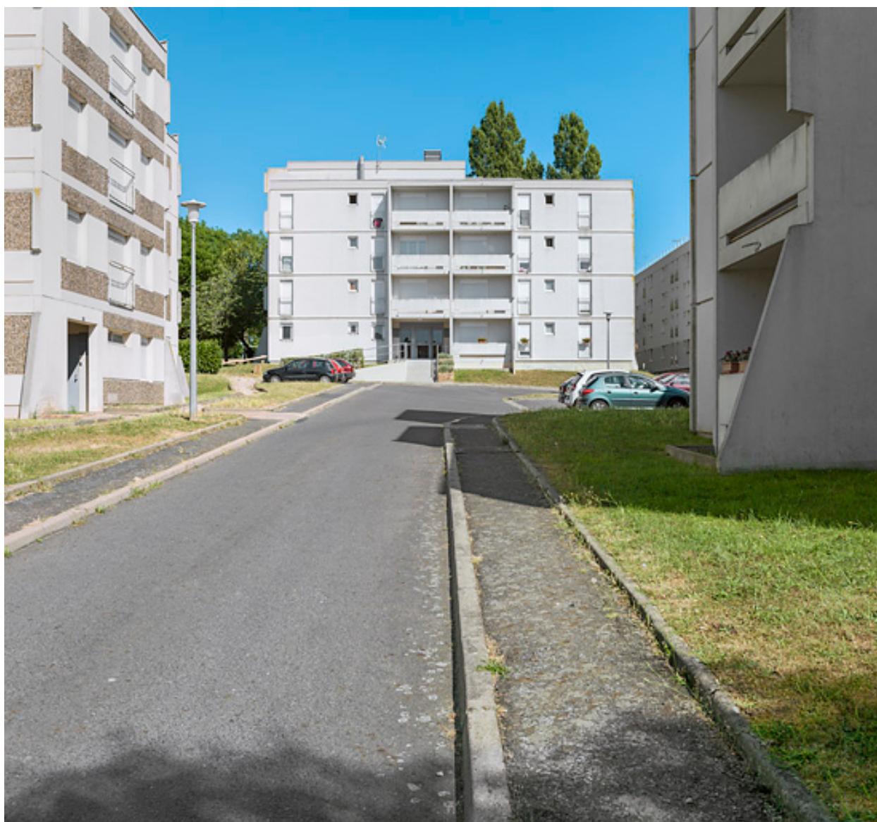
Bâtiment 27, façade antérieure ouest.
