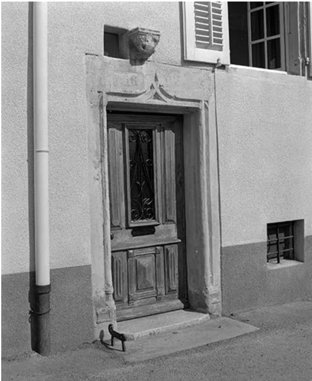
Maison située rue Robert Dame, cadastrée 1971 AB 529 : porte piétonne de trois quarts gauche.
