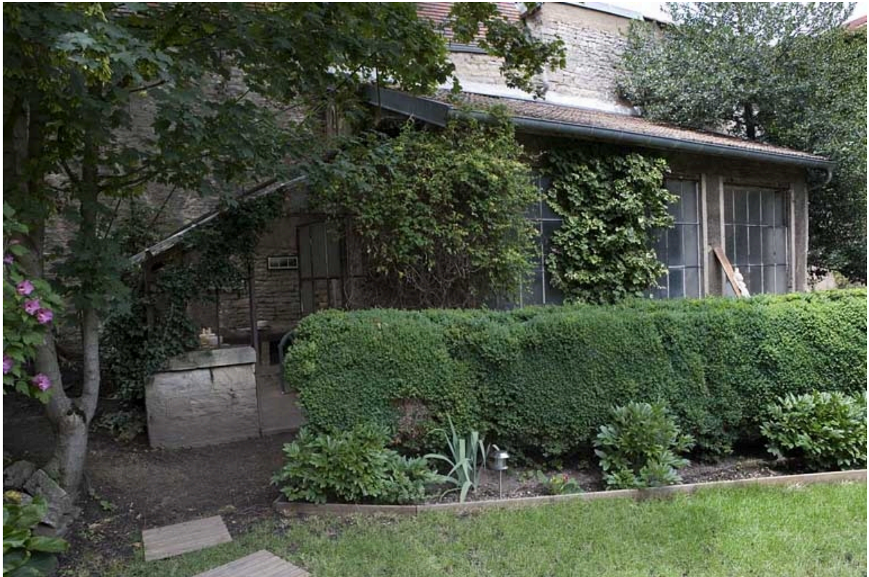
Vue d'ensemble de la serre.
