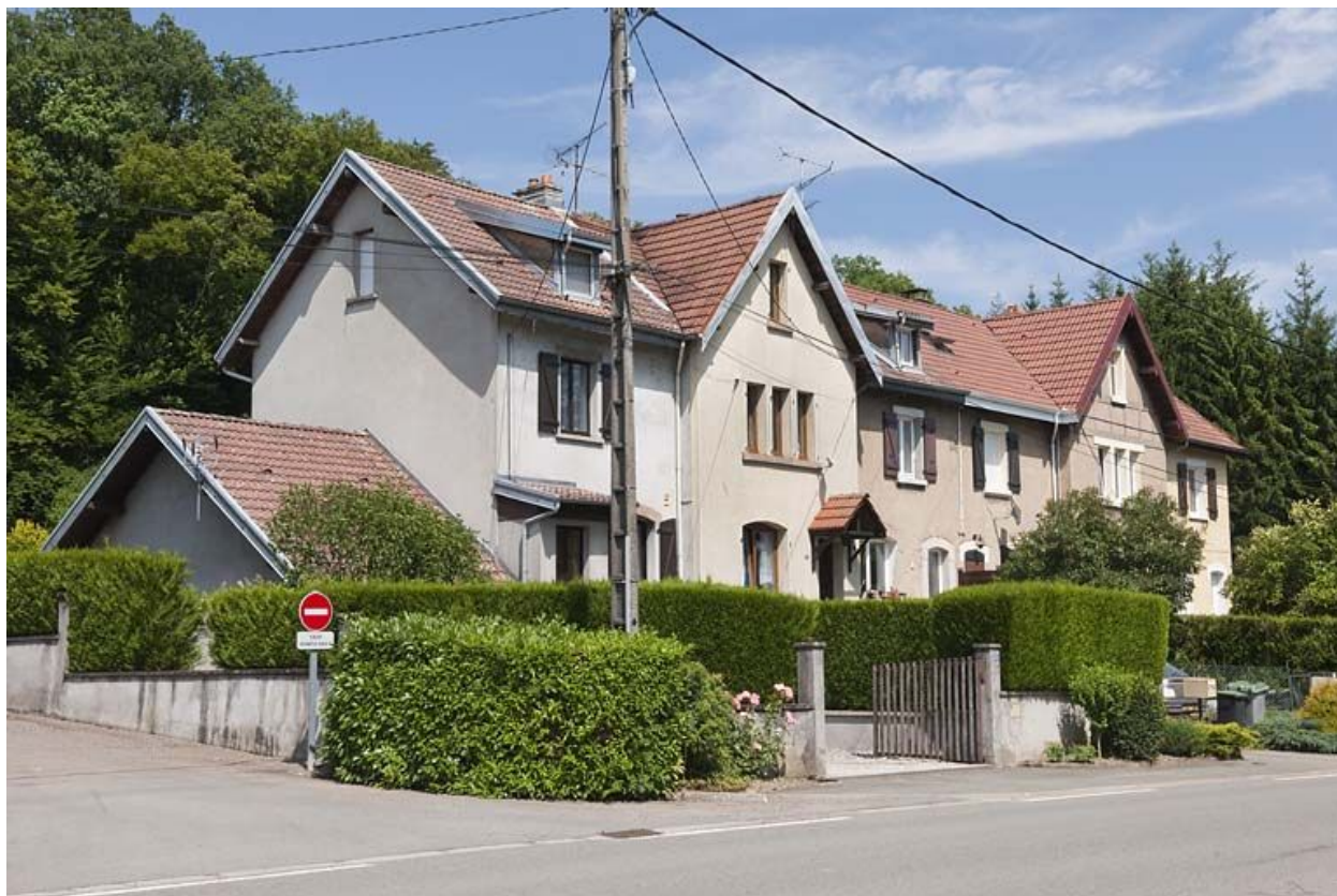
Logement ouvrier Q.
