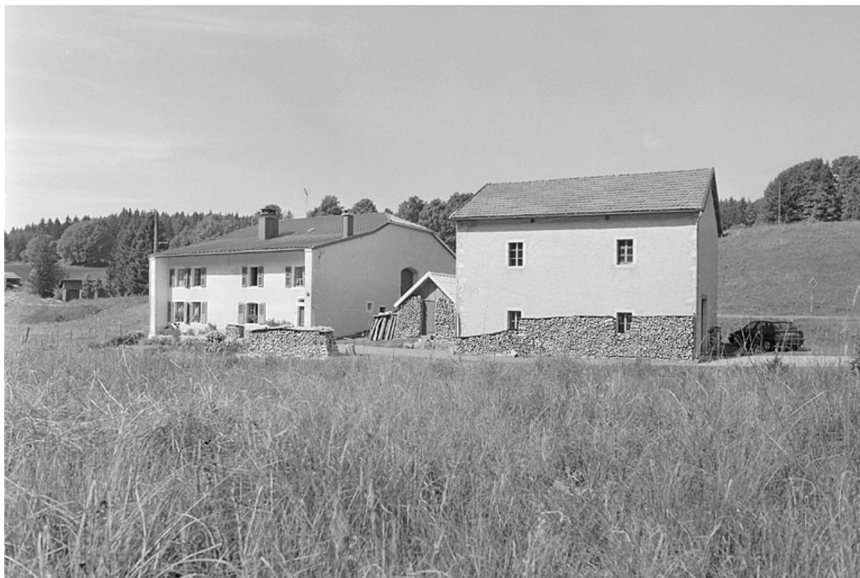
Vue générale depuis l'est.
