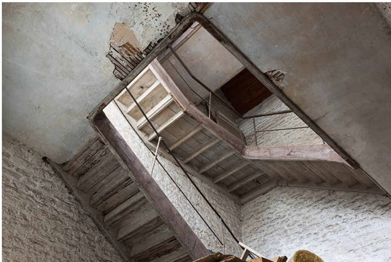
Escalier dans l'atelier des agents.
