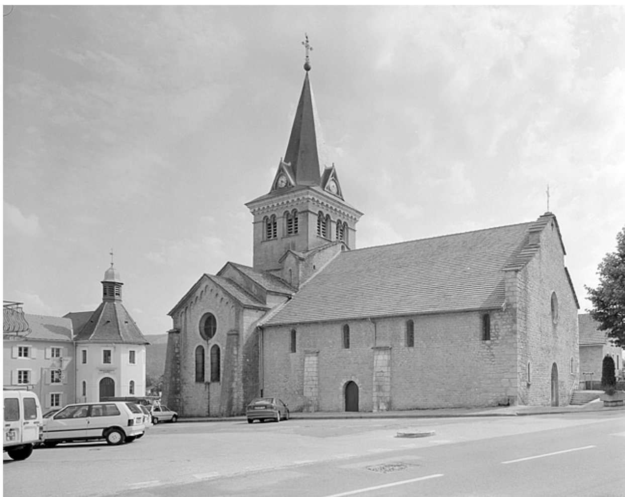
Face latérale nord de l'église.
