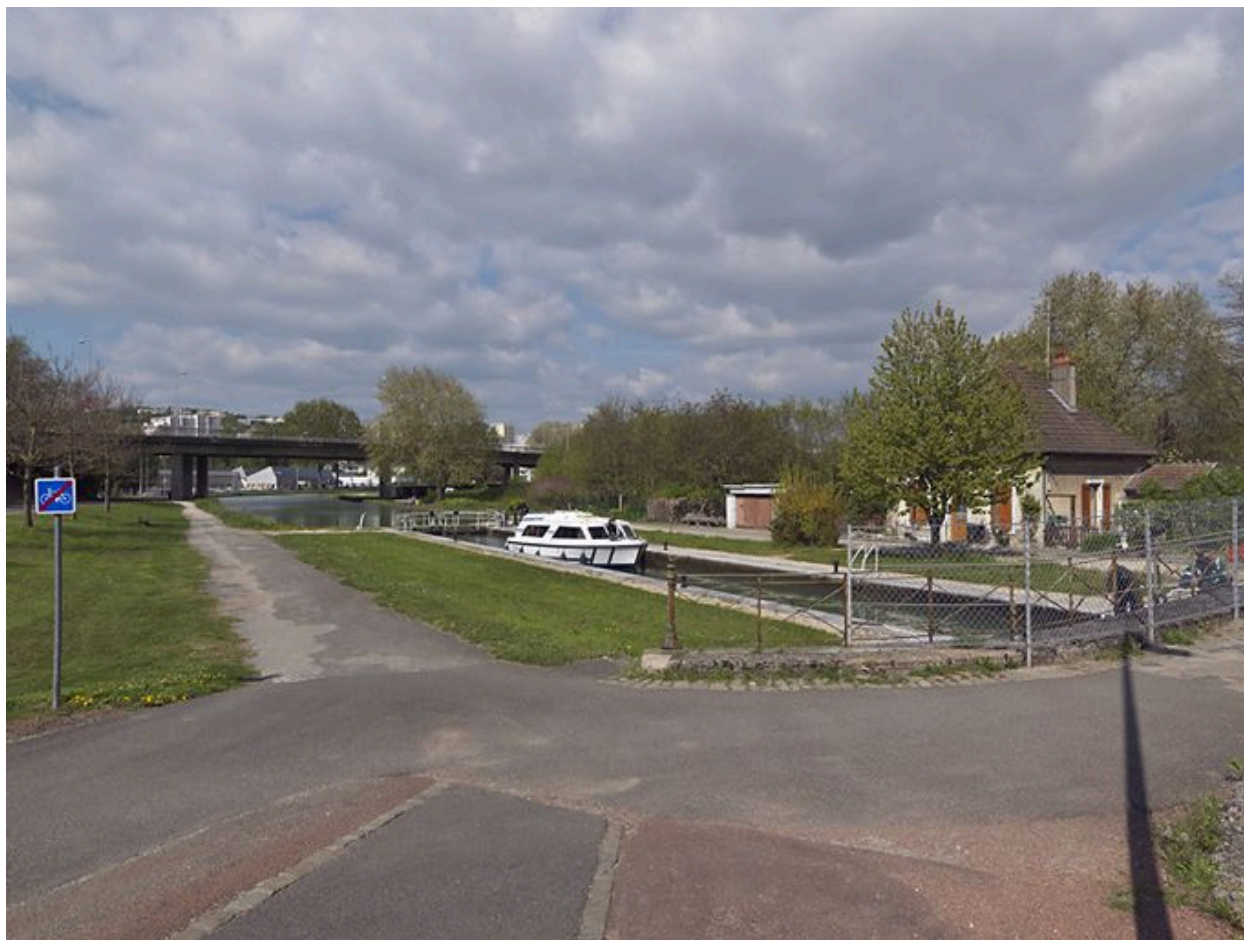
Vue d'ensemble, d'aval.
