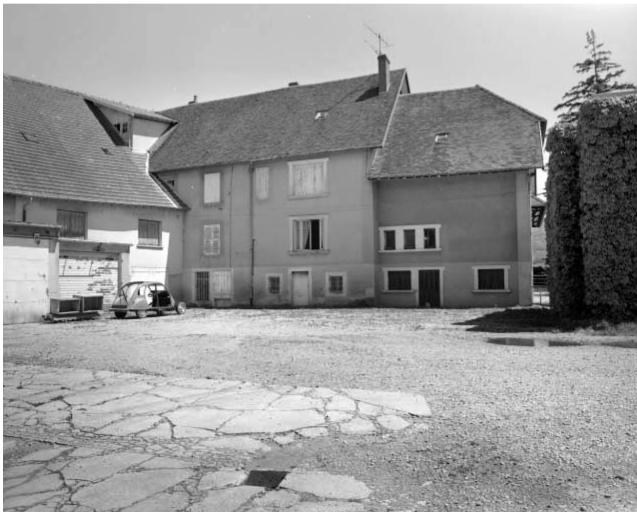
Façade postérieure du logement.
