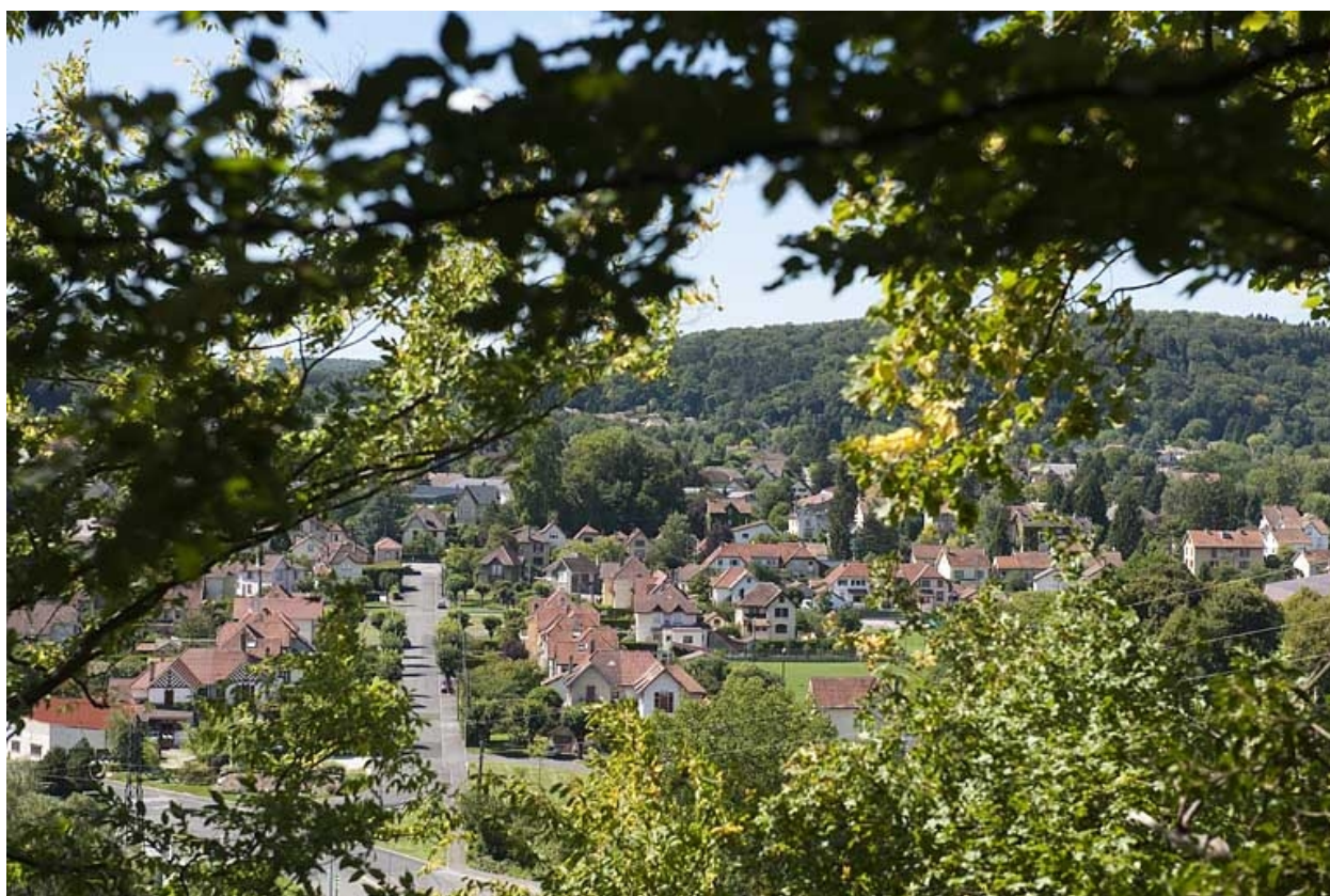
Vue plongeante sur la cité ouvrière.
