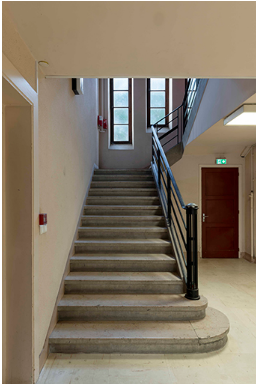
Vue de l'escalier central de la maison des œuvres depuis le hall d'entrée.
