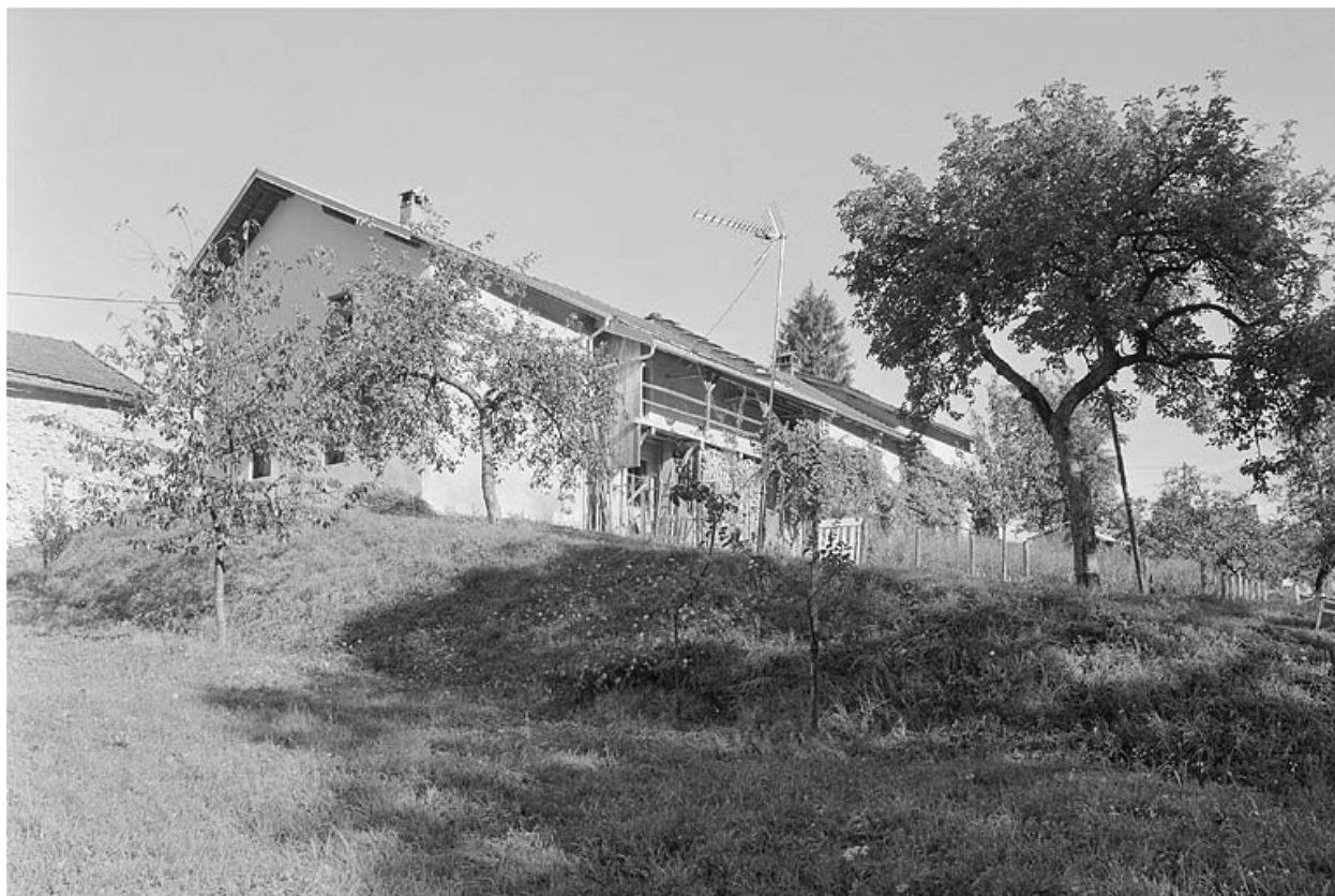
Vue d'ensemble de la façade postérieure.
