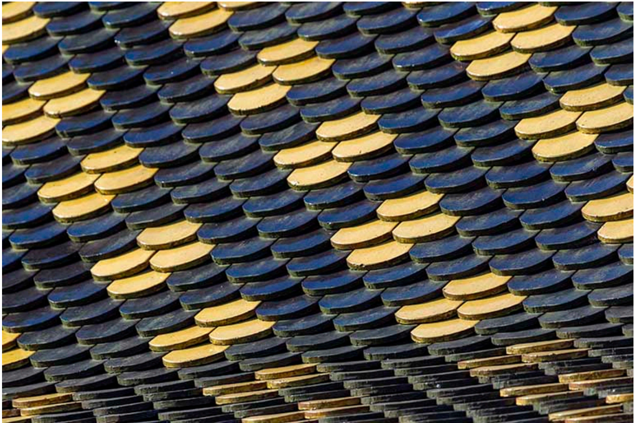
Tuiles vernissées de la toiture.
