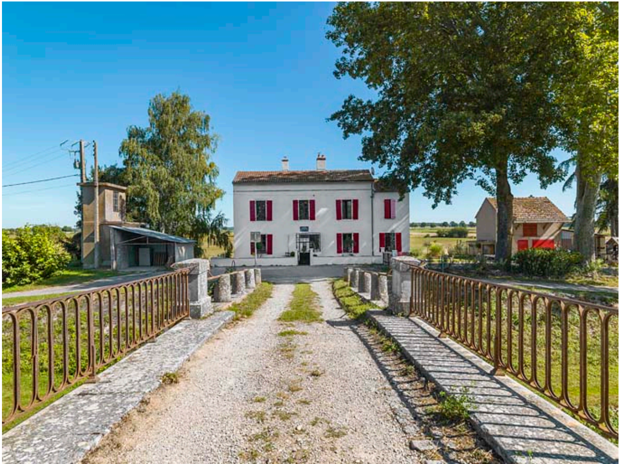
Le pont vu du dessus, au fond, la maison éclusière.
