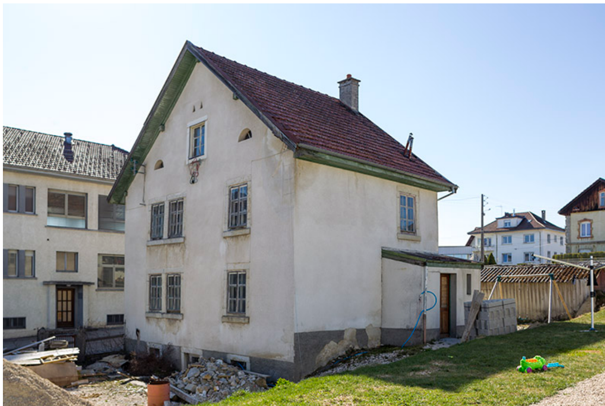
Façades postérieure et latérale droite.
