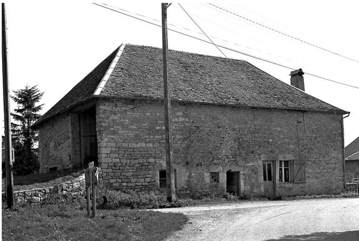
Ferme située rue Principale.
