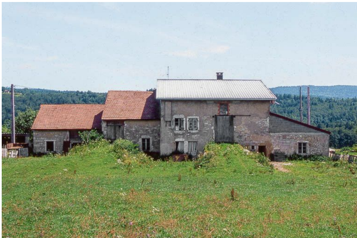
Vue éloignée de la façade postérieure.
