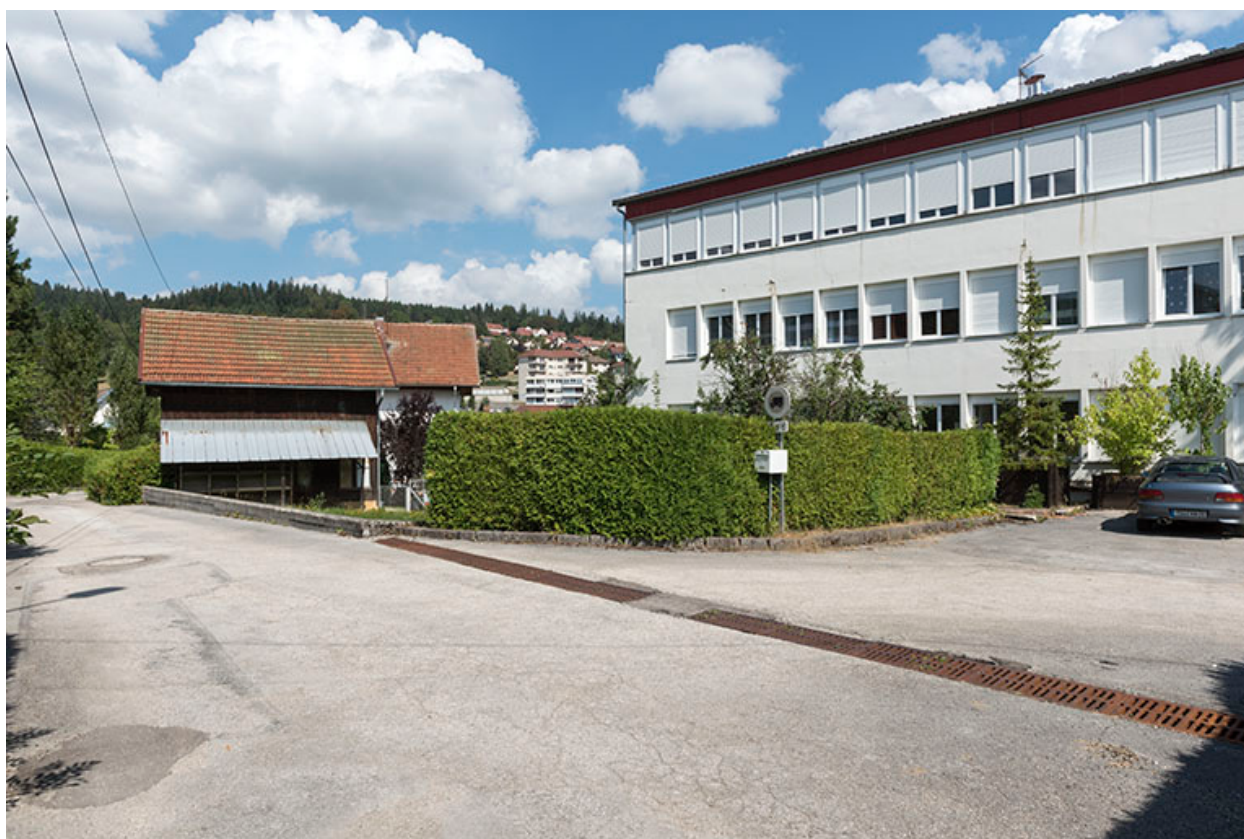
Bûcher, maison et usine (façade latérale droite).
