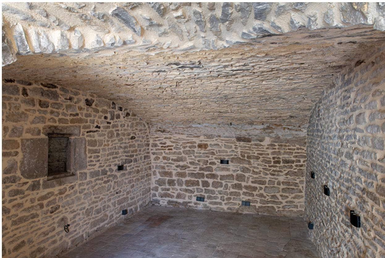
Le cellier du rez-de-chaussée, en direction du sud.
