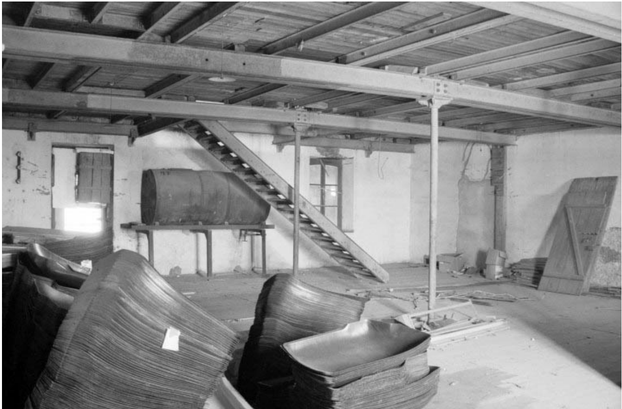
Ancien atelier de fabrication (b2) : pièce au 2e étage.
