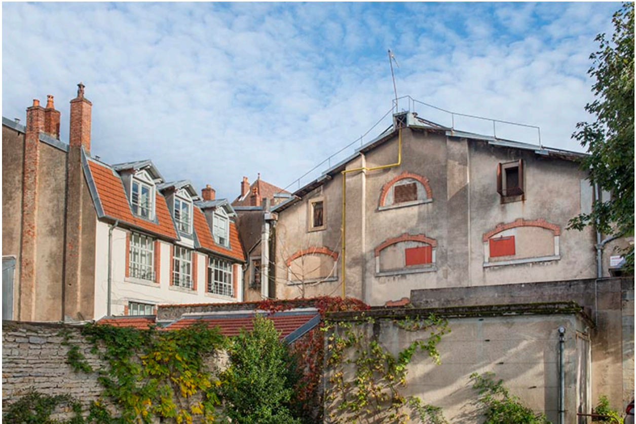
Vue d'ensemble des façades postérieures du bâtiment au 5 rue du Palais de Justice (à gauche) et de la halle (à droite).
