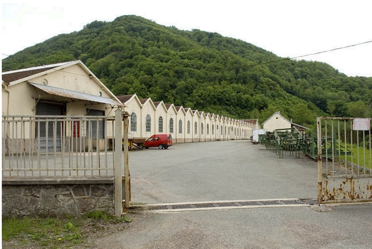
Pignons de l'atelier de fabrication depuis l'entrée.
