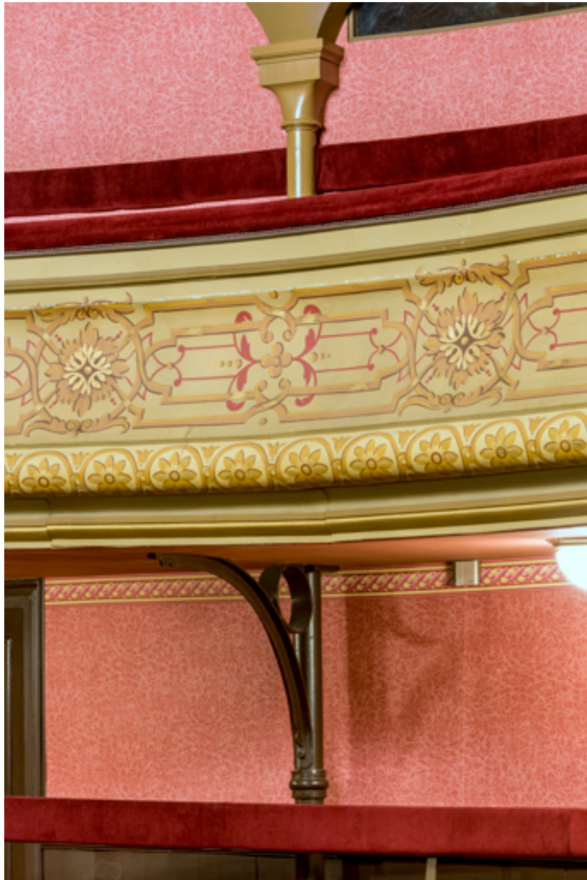
Garde-corps du 3e balcon et poteaux métalliques.
