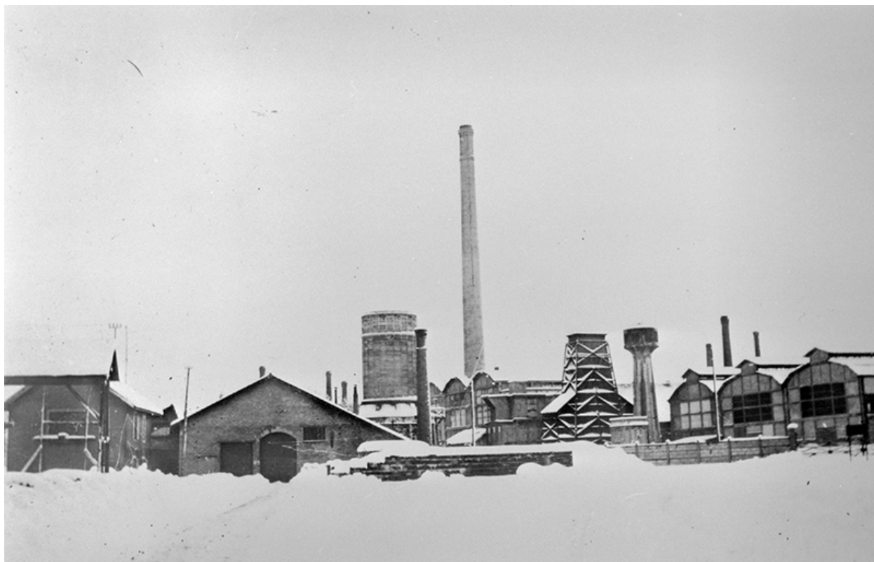
Vue d'ensemble des Aciéries depuis le nord.
