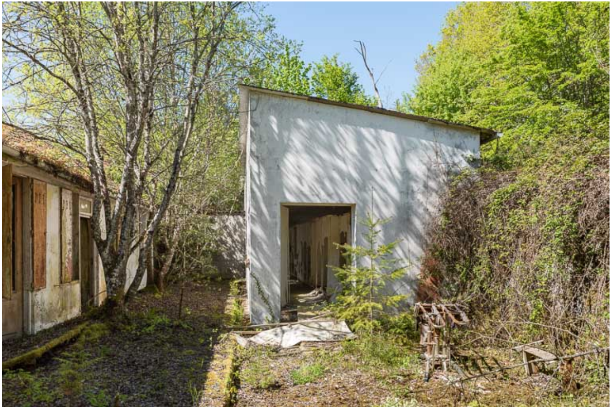
Bâtiment des bains, vue extérieure.
