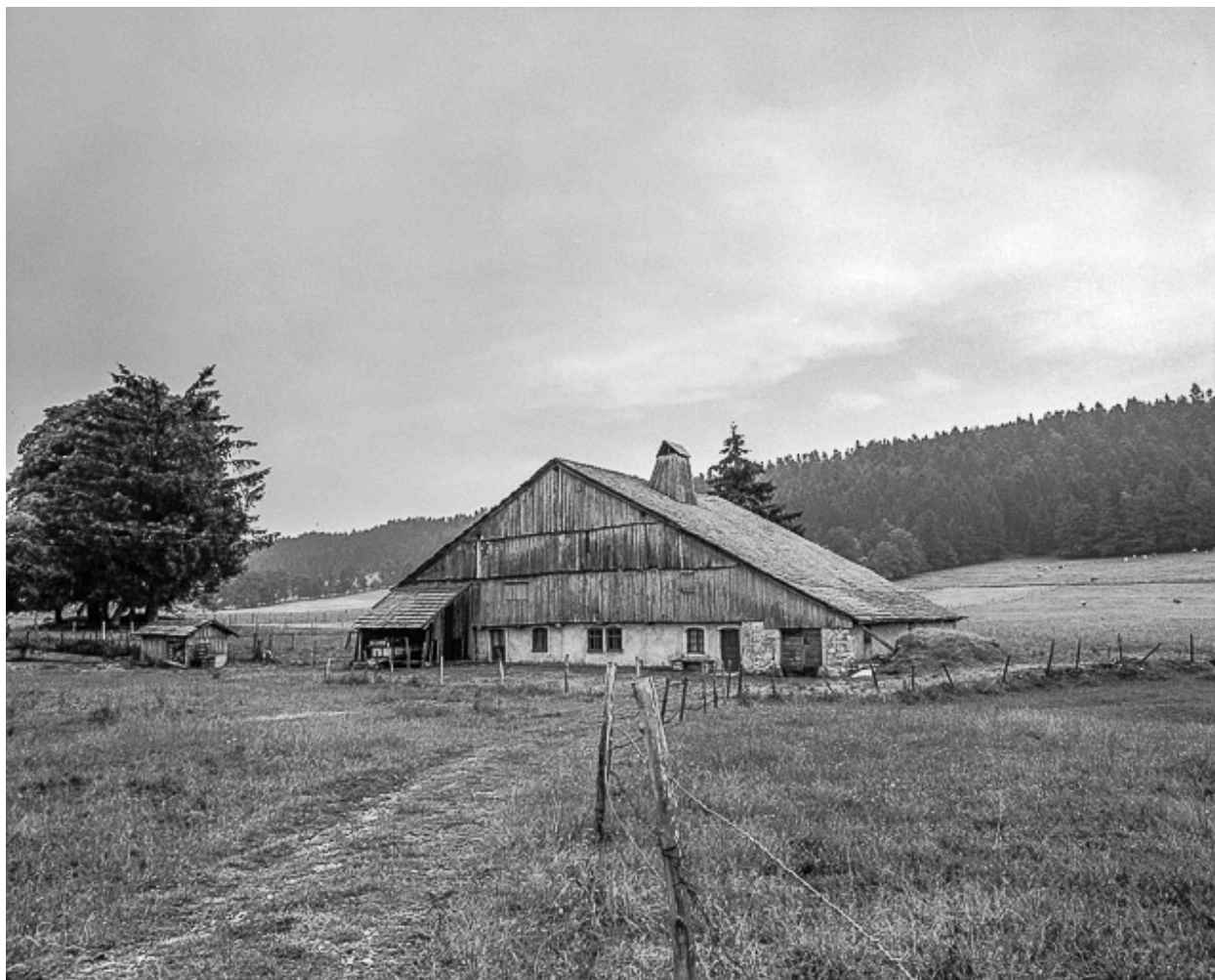
Ferme située au lieu-dit Combe d'Abondance, cadastrée B2 252 : vue d'ensemble.
