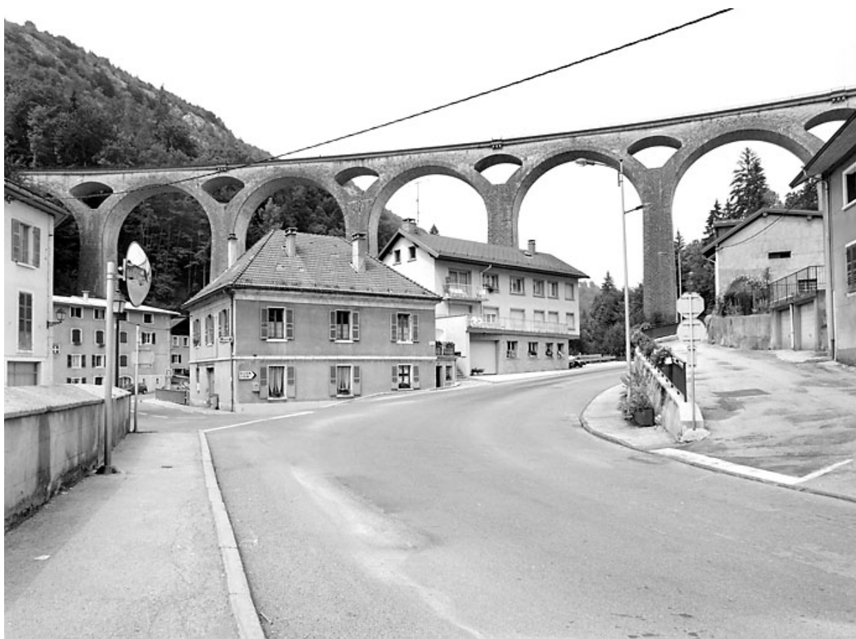
Quartier du bas de Morez : l'ancien octroi et le grand viaduc.
