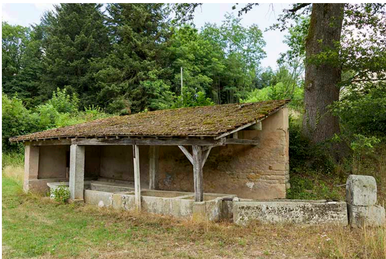
Lavoir, rue des Forges.
