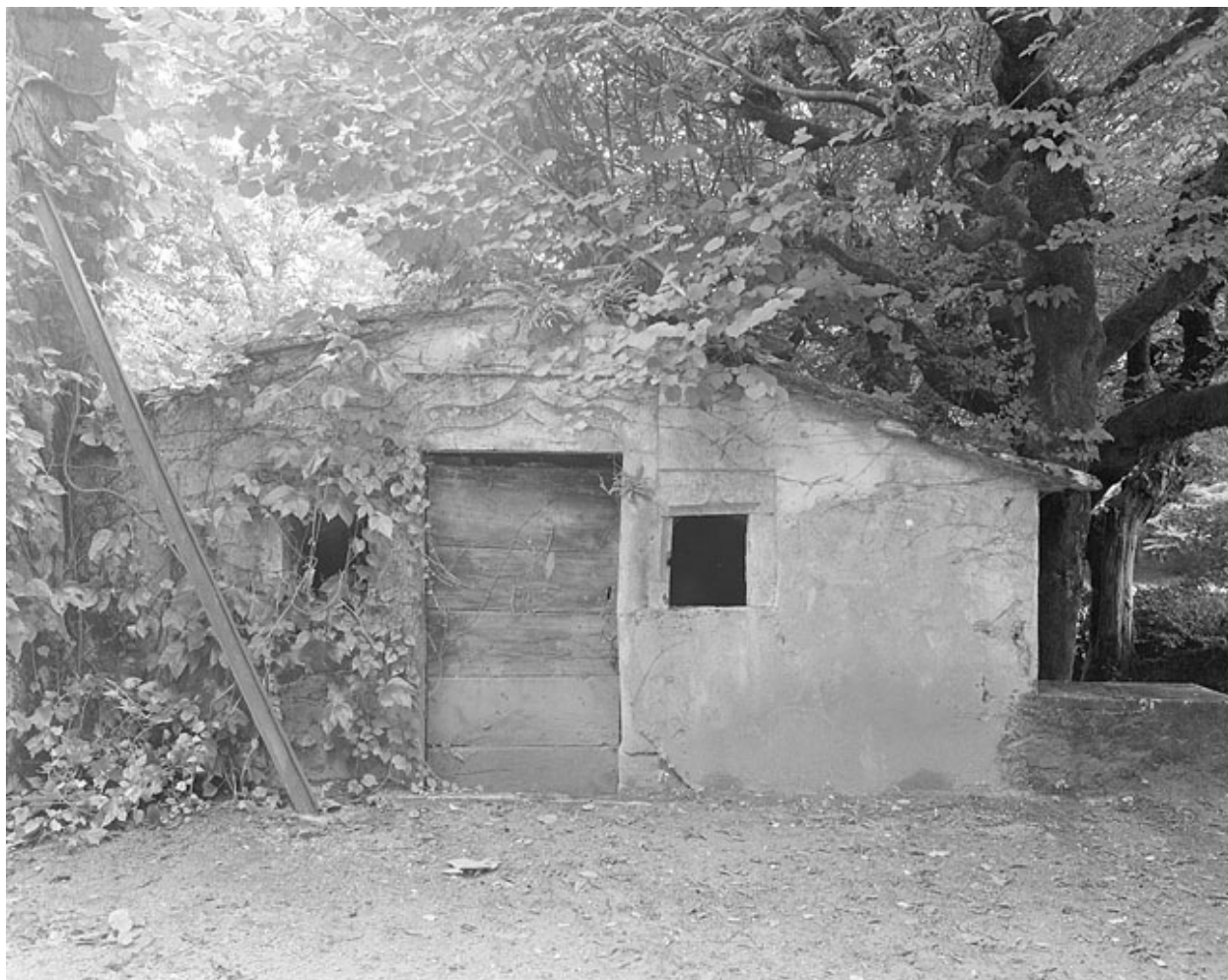
Façade antérieure du fournil.
