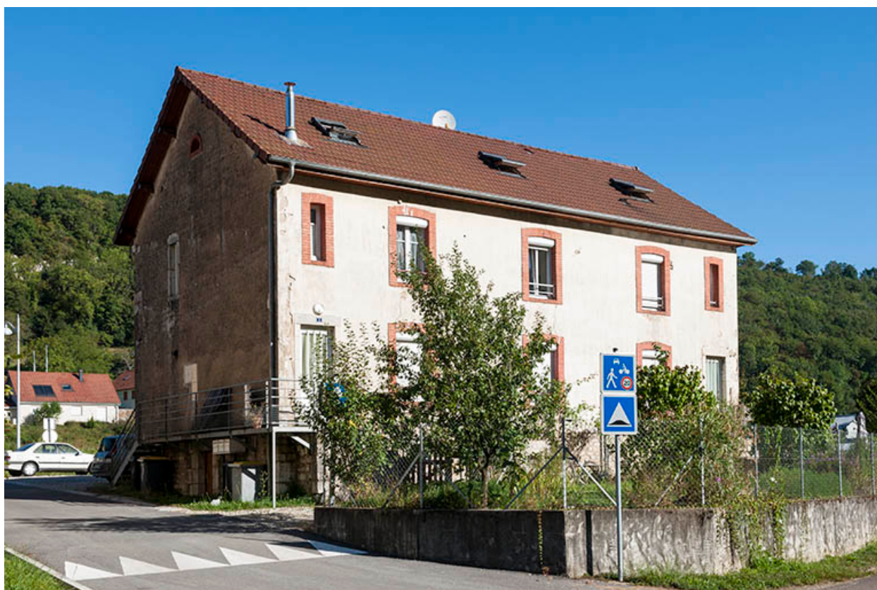
Logement ouvrier (sud) à 4 appartements. Façade est.
