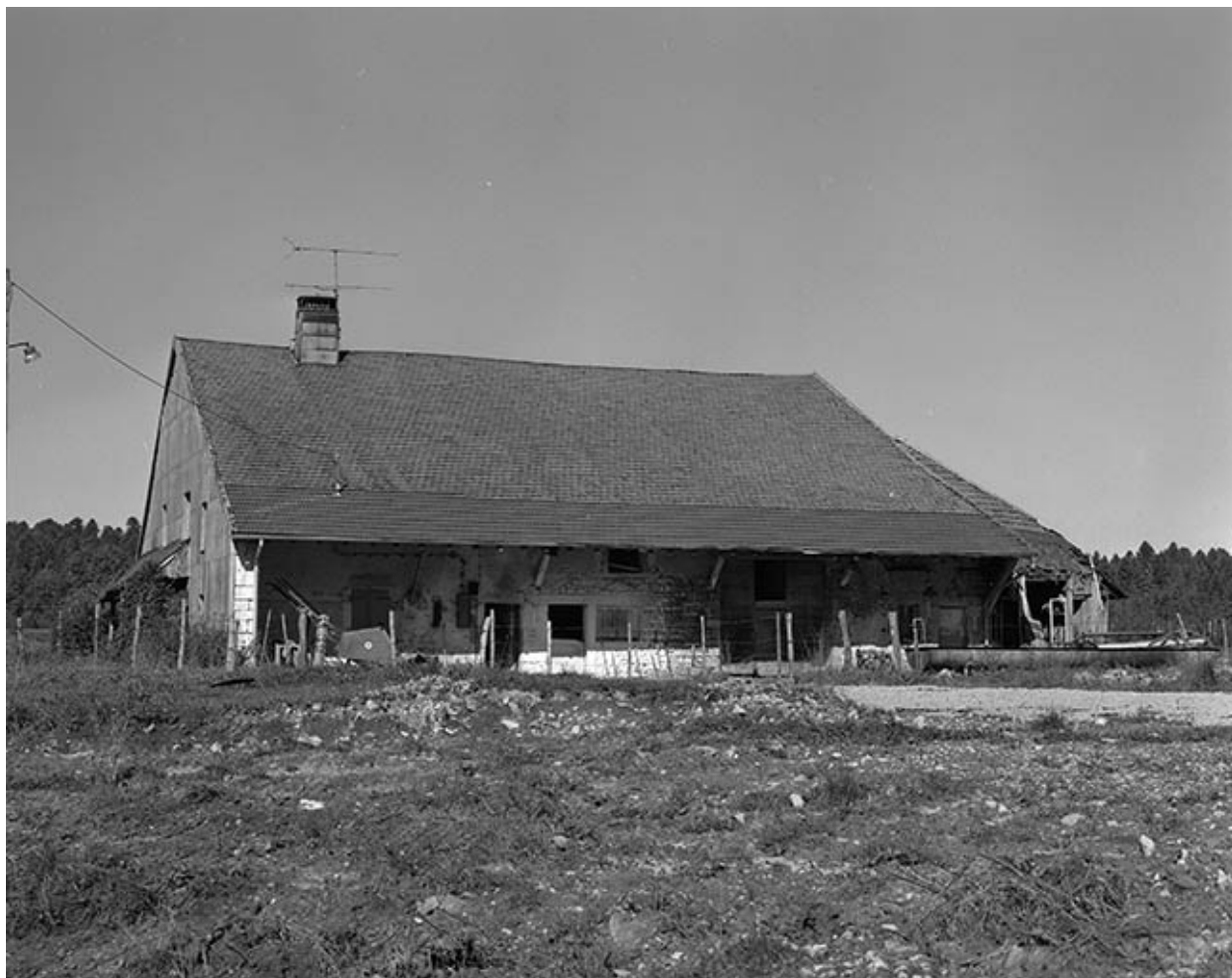
Façade latérale droite.
