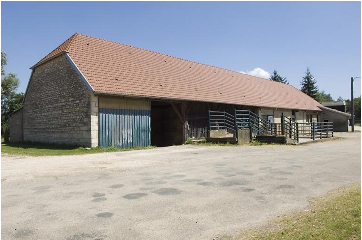
Halle à charbon (reconvertie).
