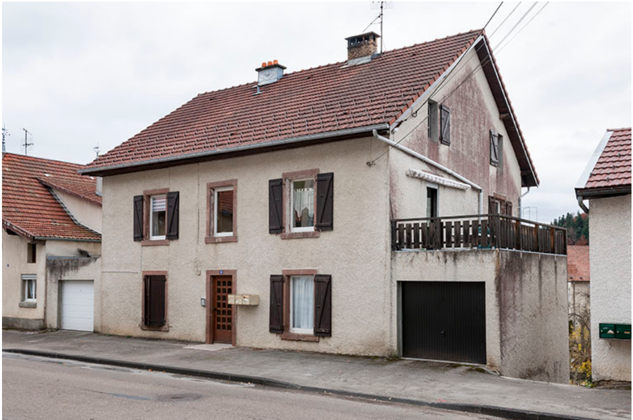
Façades antérieure et latérale droite.
