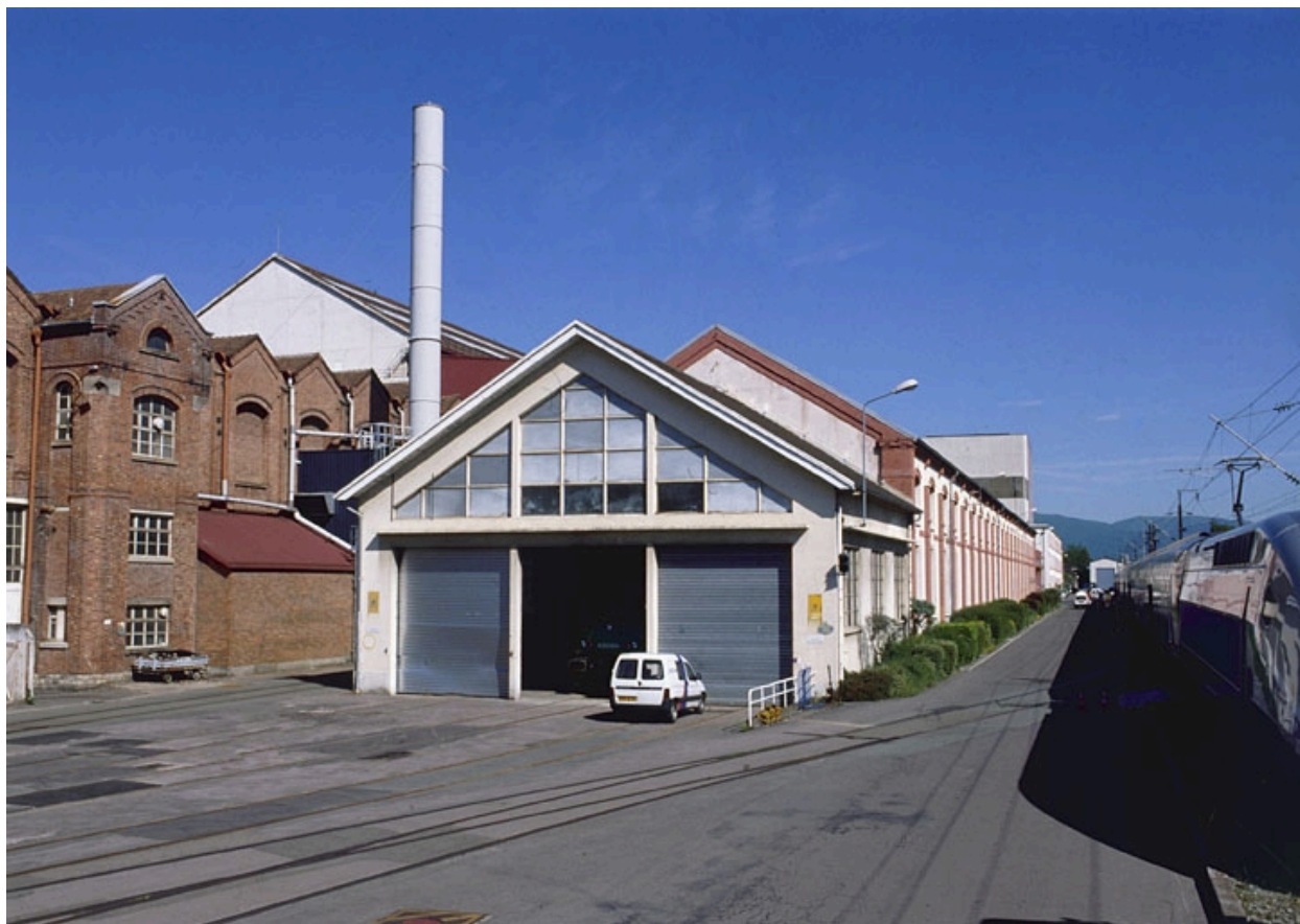
Ancien atelier des grandes dynamos et de peinture des locomotives.
