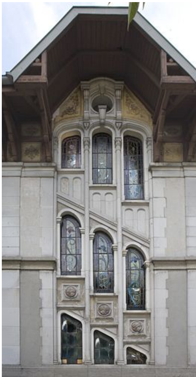
Vue d'ensemble, depuis l'extérieur.
