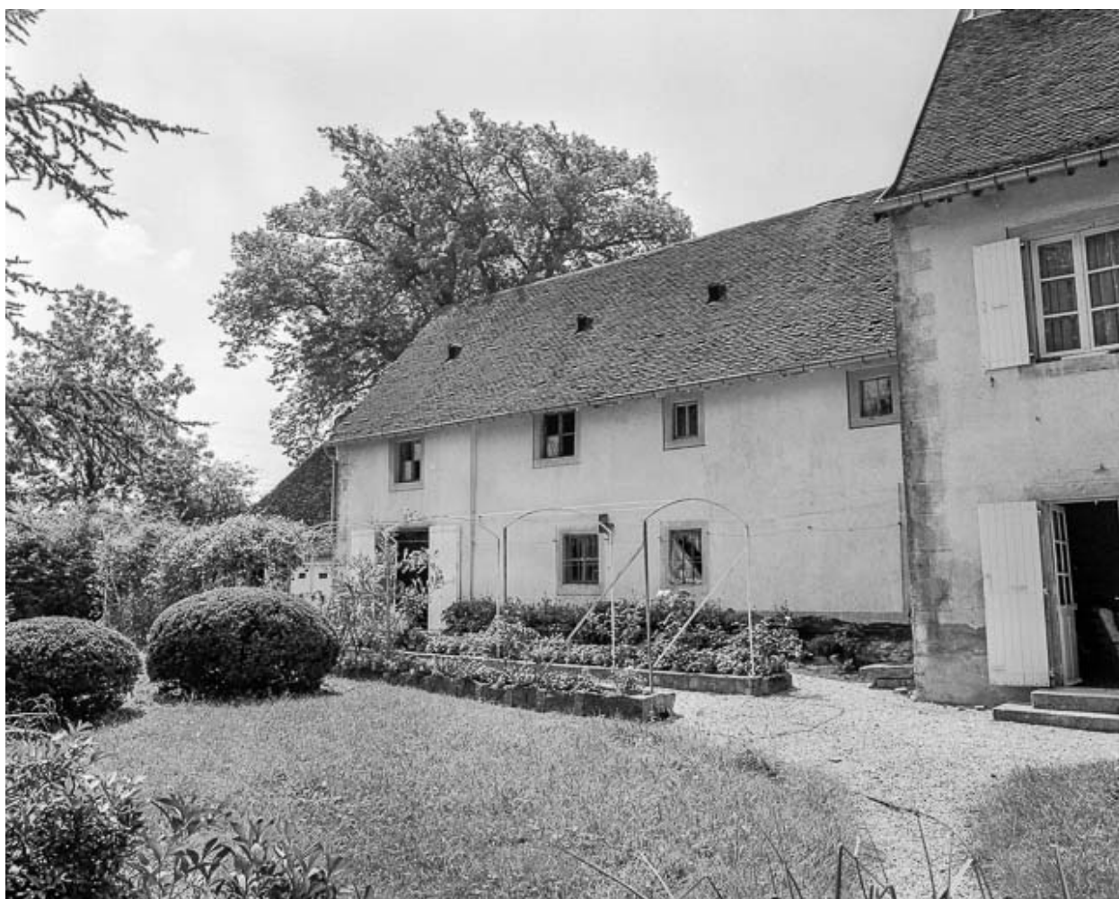
Ferme n° 16 : façade postérieure.
