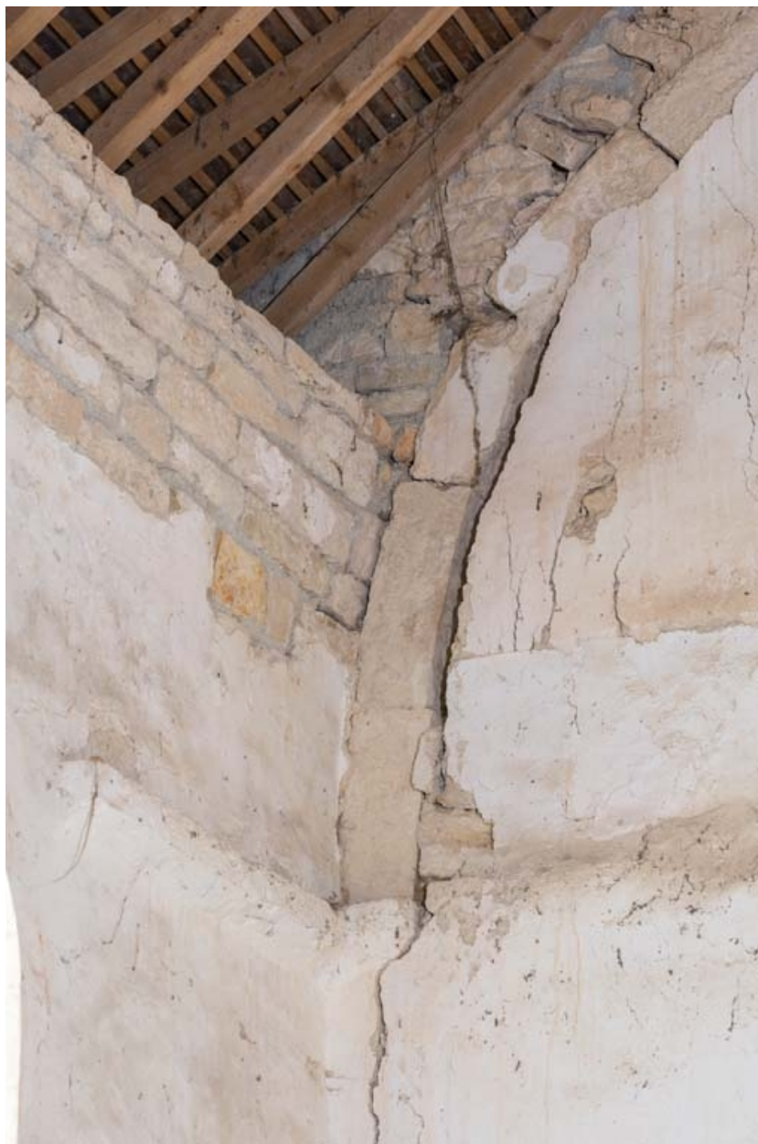
Détail du départ de voûte à l'angle sud-ouest de la nef.
