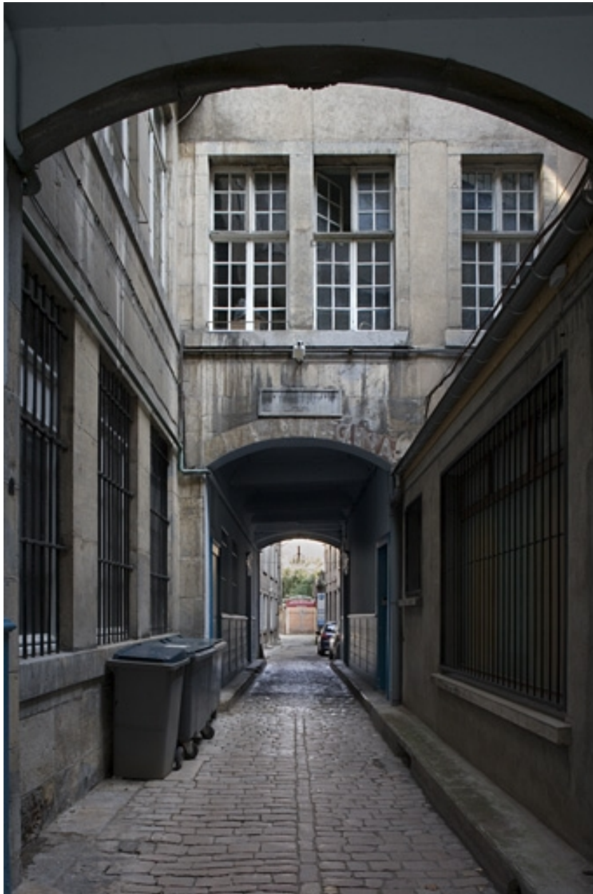
Première cour : vue d'ensemble en direction de la deuxième cour.
