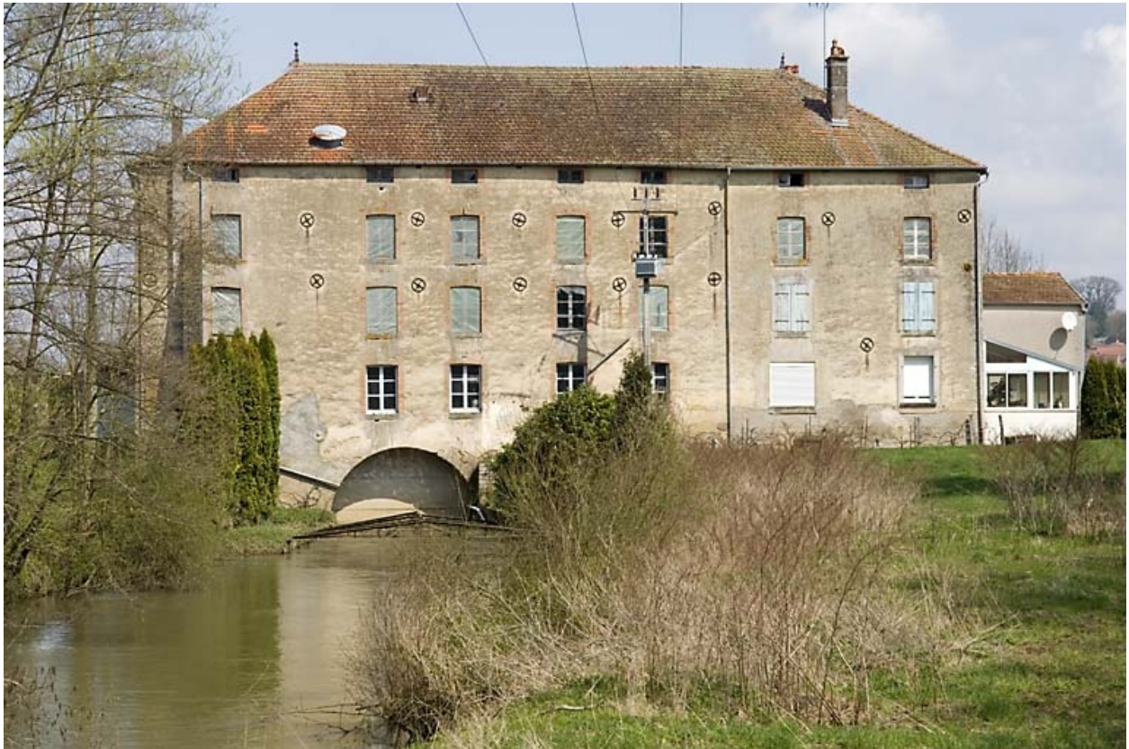
Façade postérieure vue de face.
