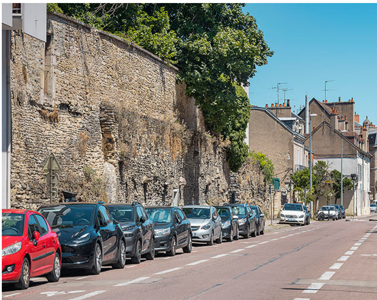
Le rempart (vue centrée), rue de Tivoli.
