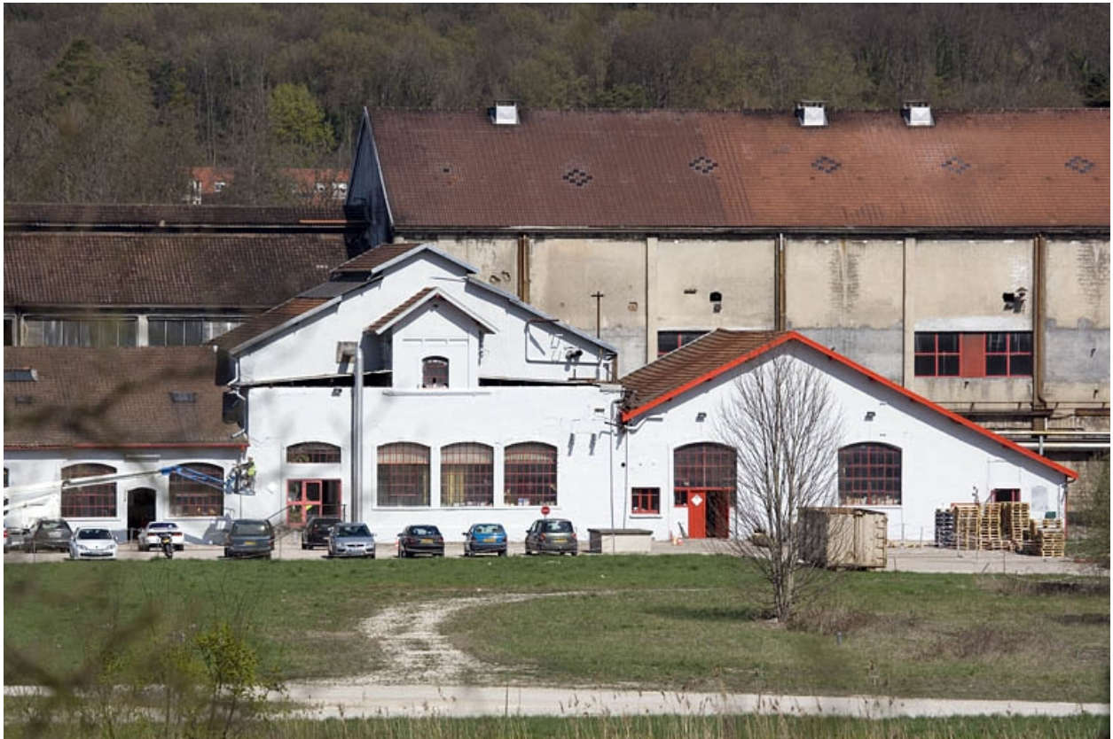
Transformateur électrique et magasin de stockage de pièces détachées. Façades sud.
