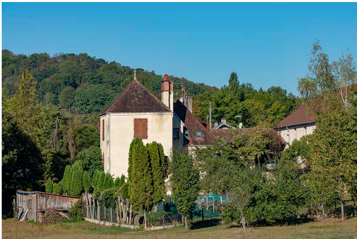
Vue prise depuis le chemin des Vignes.
