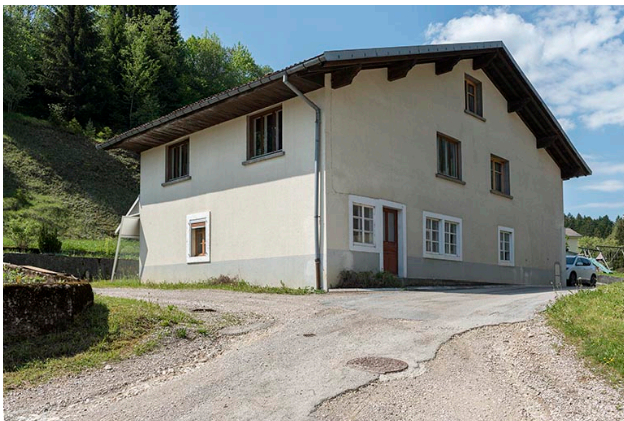
Façades postérieure et latérale gauche.
