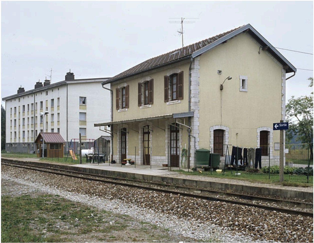
Vue d'ensemble de l'abri et du bâtiment des voyageurs, côté voie.
