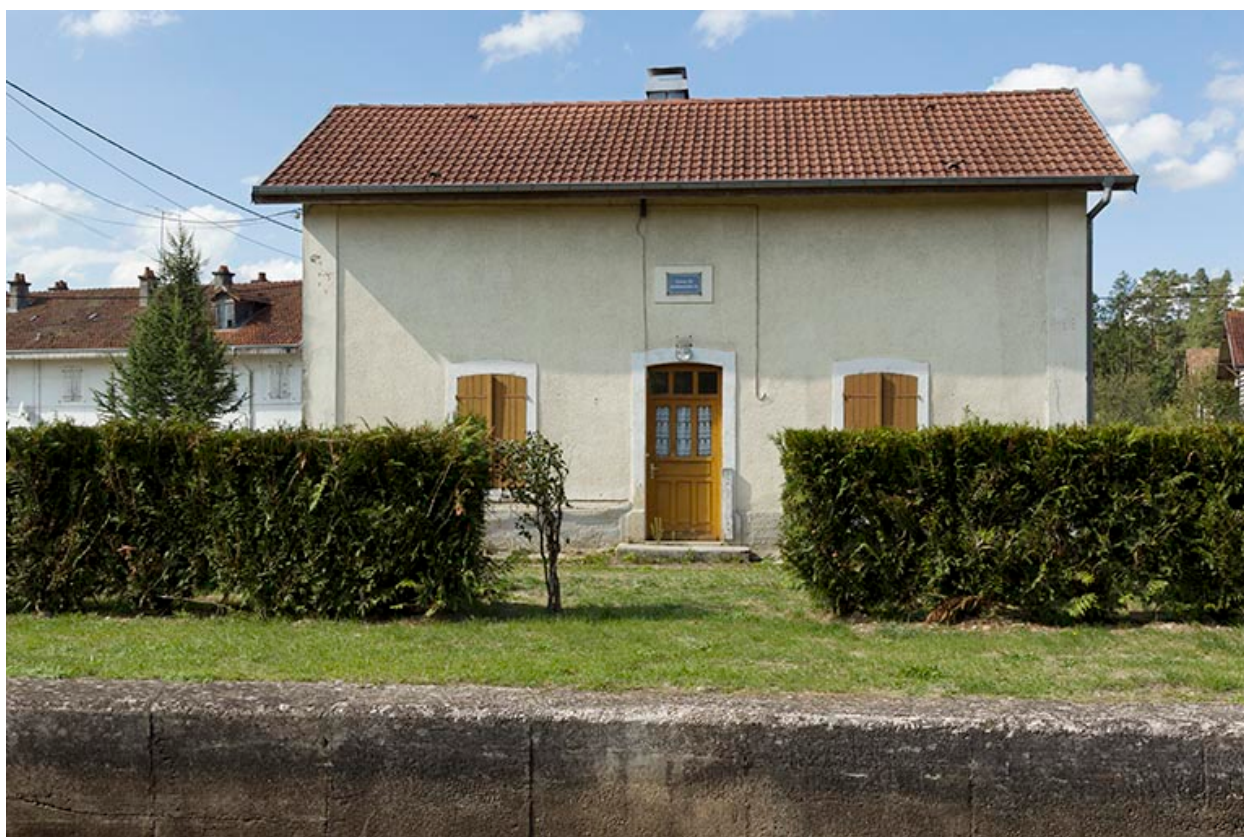
Vue de face de la maison d'éclusier.
