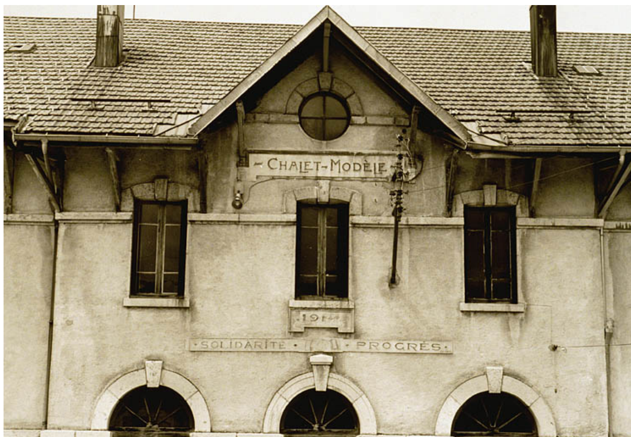
Façade antérieure : partie haute de l'avant-corps central.
