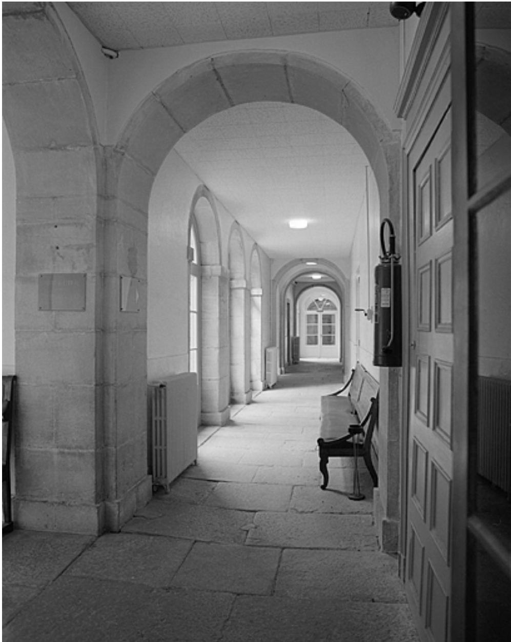
Galerie entourant une des cours intérieures.
