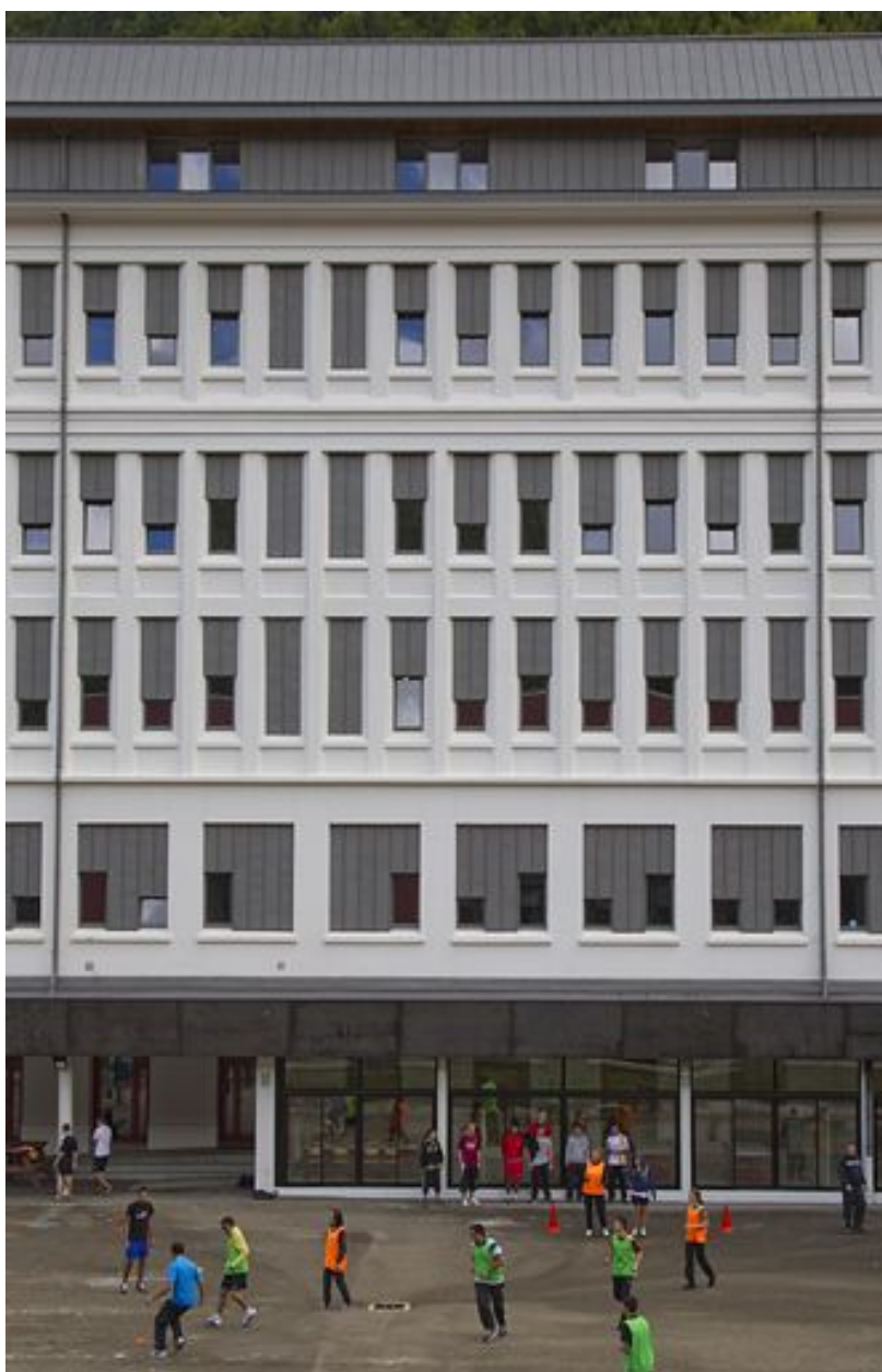
Bâtiment D : détail de la façade sur la cour, après restauration.
