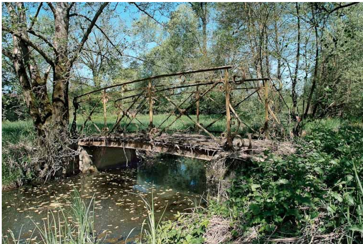
Passerelle métallique sur le Bief Michaud.
